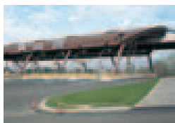
Motorway Toll Collection Area, Lucca, I Ettore Piras Architetto, Genova Trenkwaldner S.r.l., Ovada (AL) TECU® Oxid
