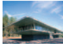
VCNON Traffic control centre, Wolfheze, NL De Architecten Cie, Amsterdam Verkoelen Dakbedekkingen BV, Beegden TECU® Zinn
